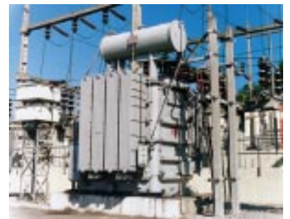
LIGHT - Arreglo - 15/20 MVA - Clase 145 kV
