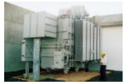
OPP Petroquímica - 40/50 MVA - Clase 36,2 kV - Con conmutación bajo carga
