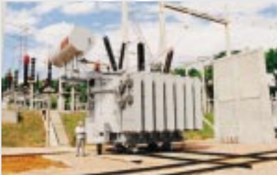
Cia. Estadual de Energia Elétrica - CEEE Arreglo - 30/40/50 MVA - Clase 242kV
